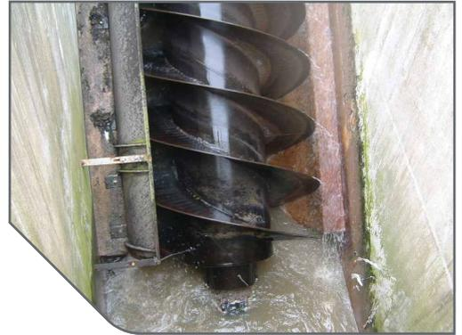
英国一污水处理厂的一台螺旋升水泵安装轴承密封(案例号: 1348)
