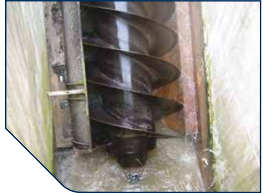
Śruba Archimedesowa z uszczelniającymi łożyskowymi AESSEAL® w oczyszczalni ścieków w Wielkiej Brytanii (nr przypadku: 1348)
