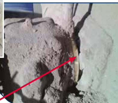
Uszczelnienie LabTecta®66OAP po trzech miesiącach pracy. Uwaga: Przedmuchiwanie powietrzem zapobiega osadzeniu się pyłu na powierzchni styku stojana z wirnikiem.
