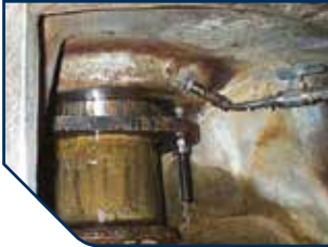
Zanieczyszczenie wodą w warniku ciągłym przed zamontowaniem uszczelnienia LabTecta®66 (nr przypadku: 3232)
